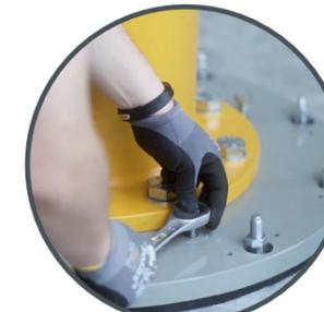
**Schnelle und einfache Ausrichtung** der Verbund-Anker-Platte durch integrierte Ausrichterschrauben.
